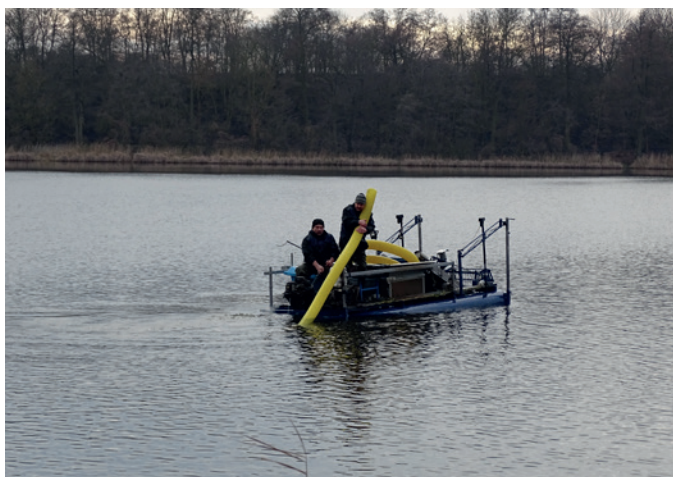
Montowanie plastikowej rury, doprowadzającej wodę bogatą w azotany na dno jeziora
